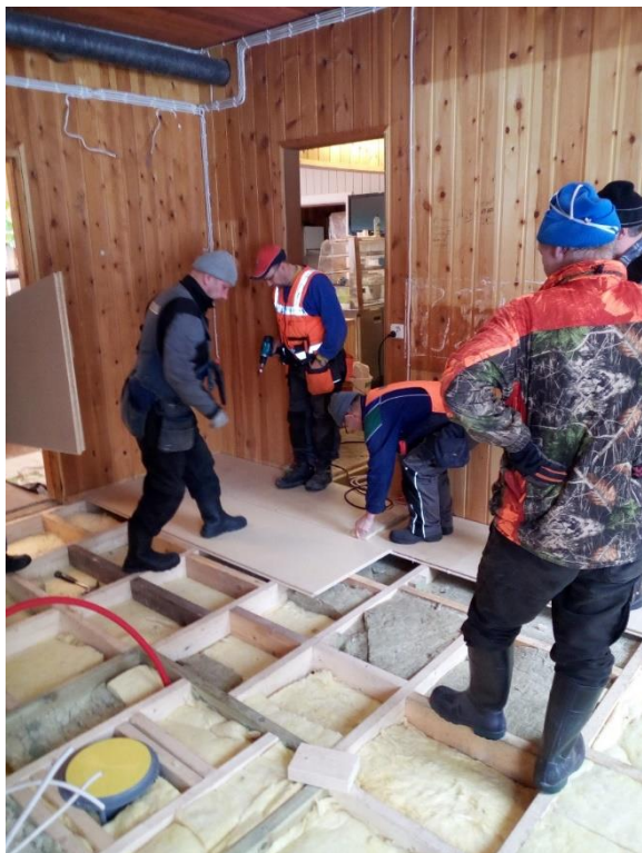
Uuden keittiönlattian asennusta
